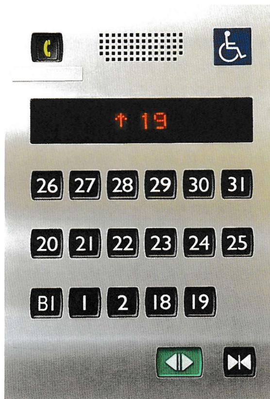
**Memo** 今日のエレベーターは▶もし制御板が壊れても自動的に電源が切れ1.3倍速以上にはならない。▶カゴを吊る鋼製ロープのすべてが切れても、制御器が強制的にレールを挟み込んでゆるやかに停止する。▶万一、それらのすべてが不能になっても底の部分の緩衝装置が柔らかく受け止める——と幾重もの安全装置が働くことになっています。
